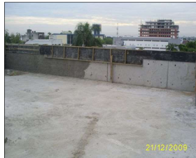
Platibanda de concreto armado.
