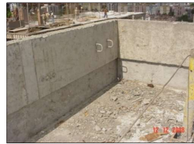
Platibanda de concreto com rebaixo no rodapé até a altura de 40 cm.
