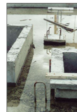
Moldura em concreto, solidária à laje
