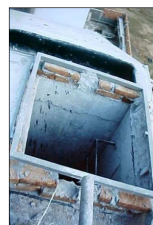
Moldura em alvenaria de tijolos maciços
