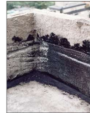
Platibanda com a ancoragem da impermeabilização efetuada no rebaixo para essa finalidade.
