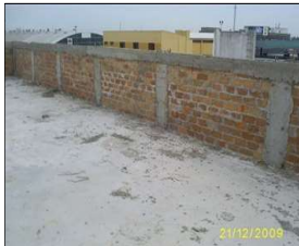
Platibanda mista (alvenaria de tijolos maciços + pilaretes de concreto).
